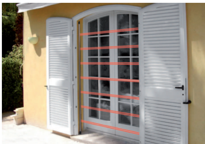
Zunanje varovanje objekta z javljalniki TRIRED in WIN(DOOR)BEAMS
