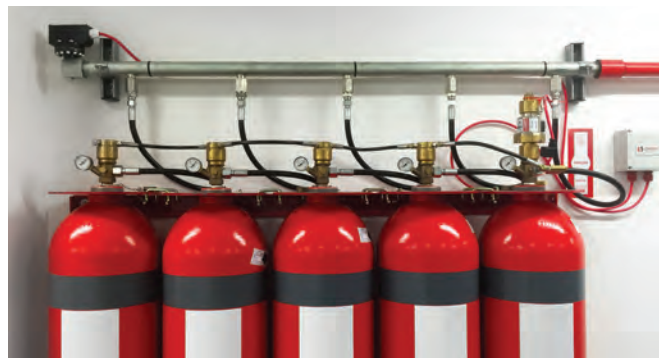
Jeklenke Inergena povezane v sistem
